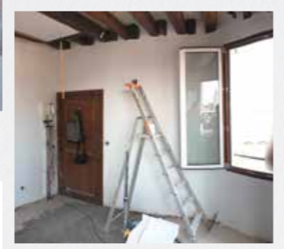
Avant, Côté porte d'entrée
